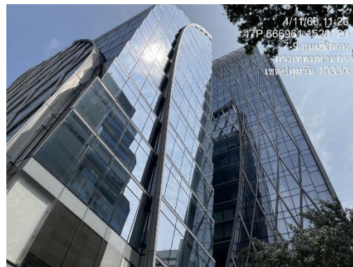
รูปที่ 32 ตัวอาคาร เลือกใช้กระจกประกอบอาคารดูดซับความร้อนต่ำ
